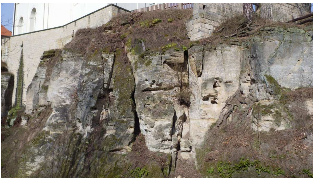
Vertikální pukliny v JV části 2. skal. bloku budou vyzděny novým kamenem.
