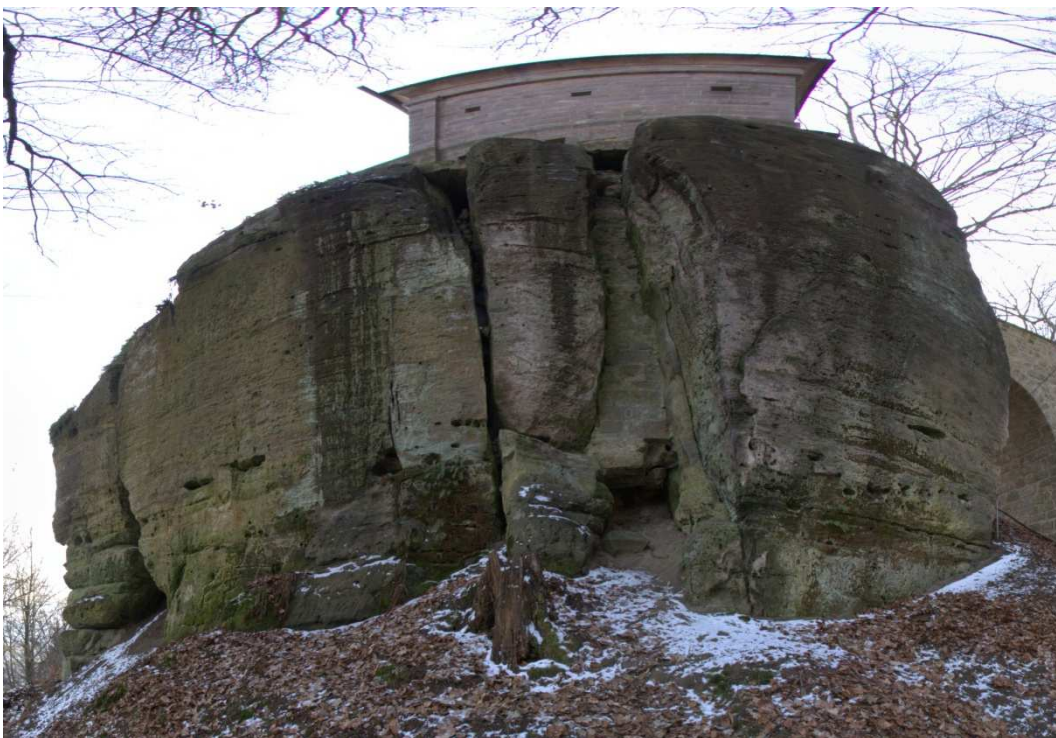
Stávající podezdívka v SZ části 1. skal. bloku bude v patě a koruně opravena.
