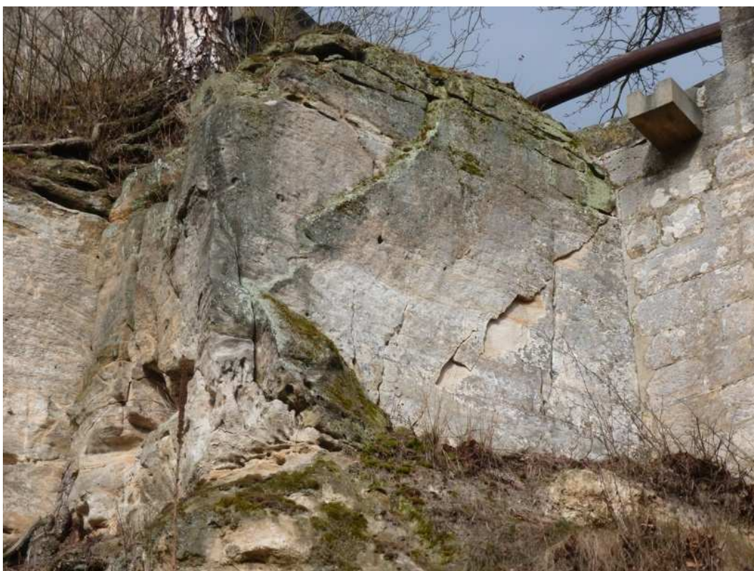
Čerstvé pukliny indikují pohyb bloku v JV části 2. skal. bloku, bude odtěžen.
